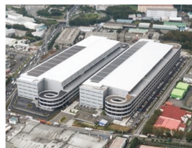
太陽光発電設備を備えているSGリアルティ柏
